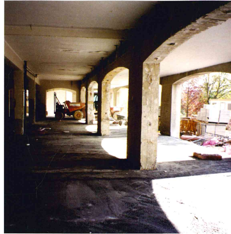
◀ Egoitzaren beheko solairua. Planta baja de la Residencia.
