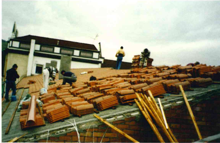
Teilatu zati bat luzatzen eta dana barrizatzen. Ampliación del tejado.
