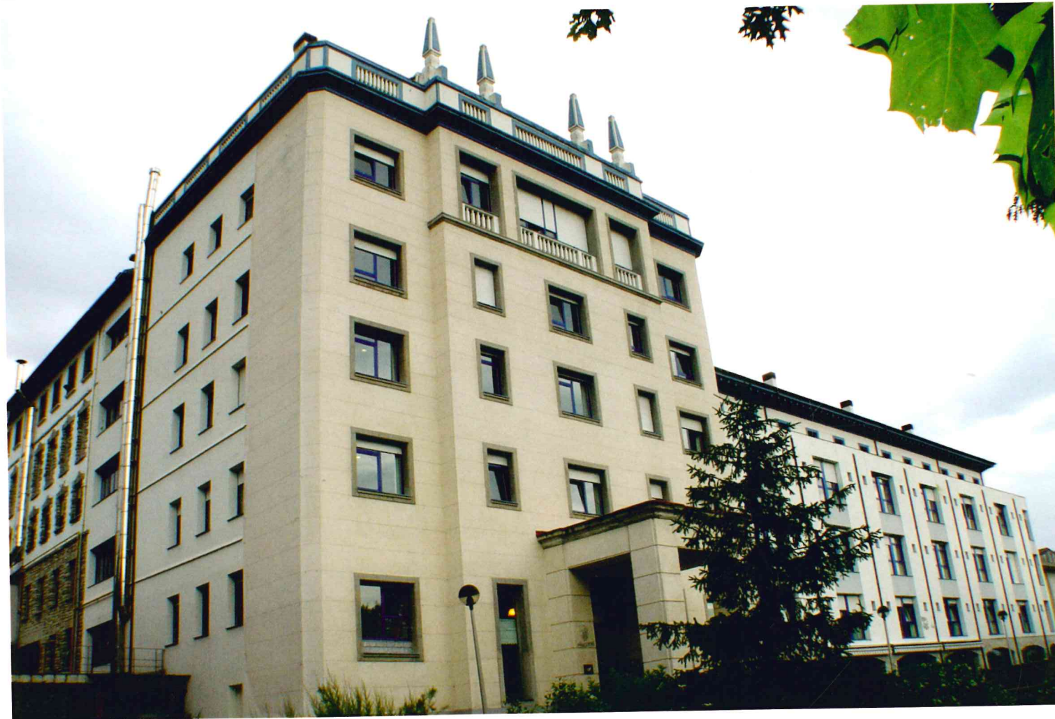
◀ Sarrera eta fatxada barriak. Entrada principal y nuevas fachadas.
