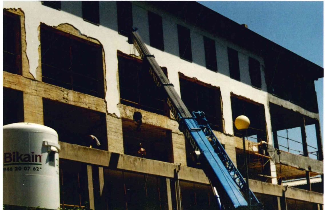
Fatxada eta barruko alde apurtzen eta hutsitzen. Demolición de la fachada y del interior del edificio.
