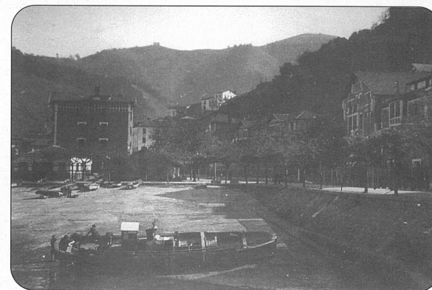
Arlanpa zabaltzen. / Ampliando la rampla.
