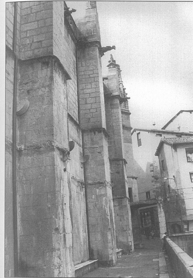
Parrokiko ormak. / Muros de la parroquia.
