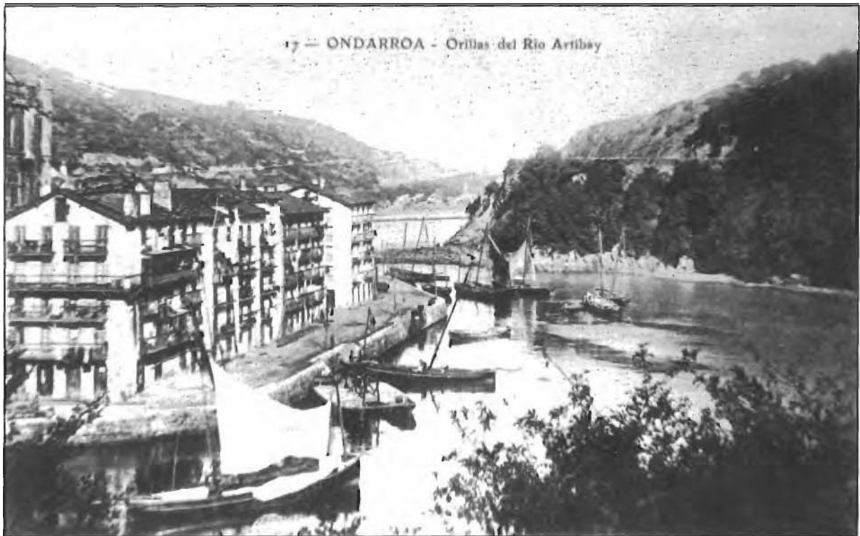
Kafeko atzea. - "San Pedro" Kofradia egin aurretik. Antes de la construcción de la Cofradía San Pedro.
