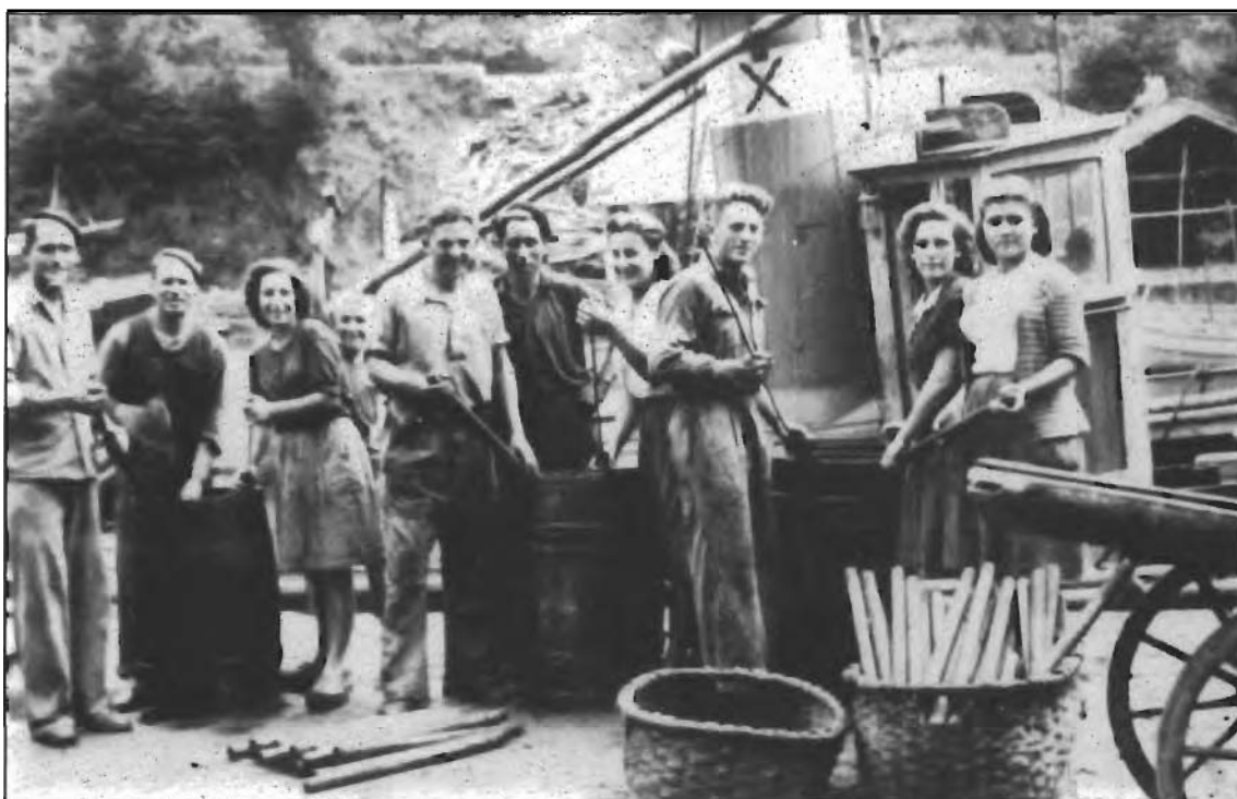
Baporen galdaretako tutuak garbitzen. Limpiando tubos de las calderas de los vaporcitos.
