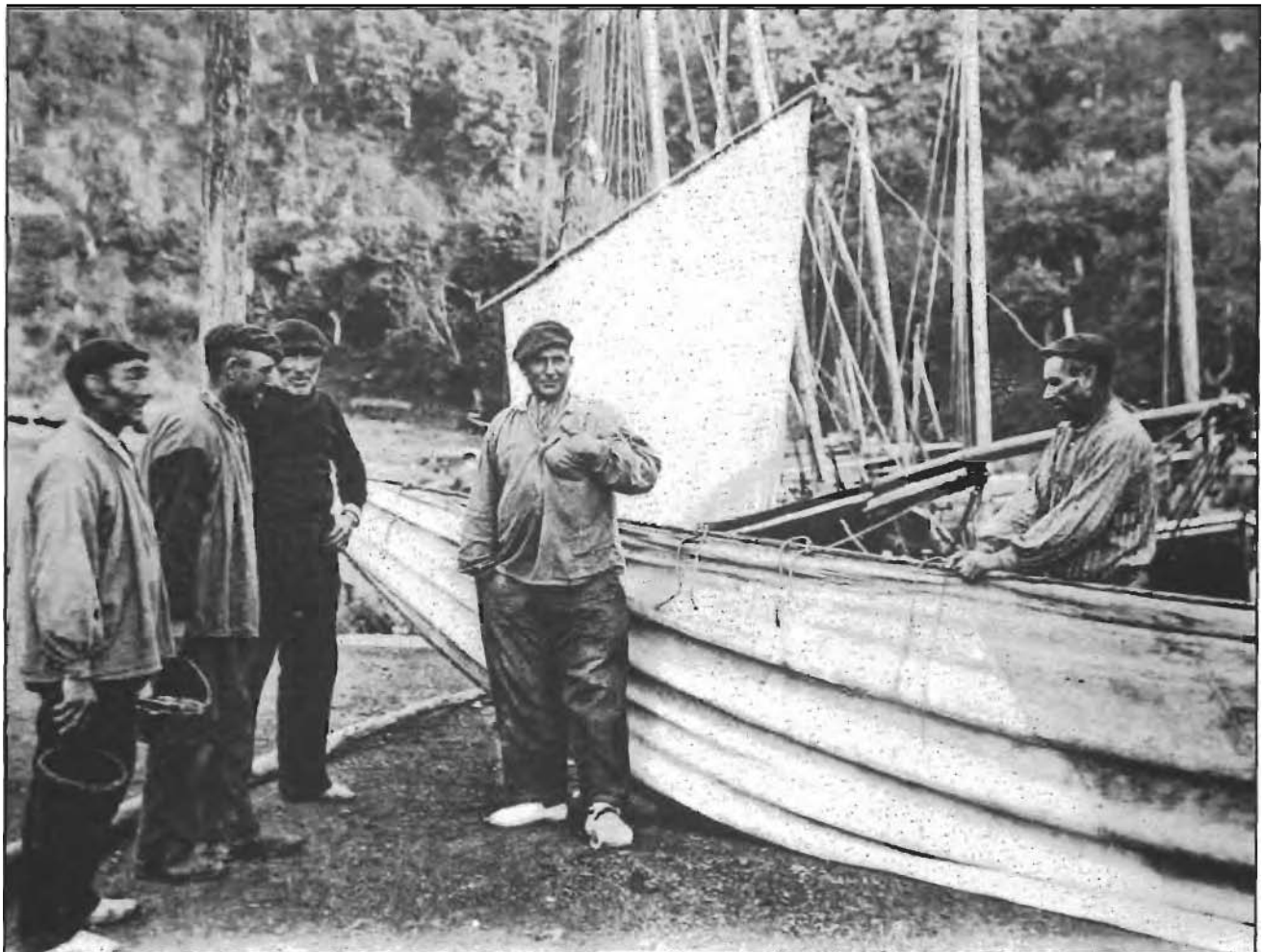
Lengo denporetan, belak sendotzen. Reforzando velas.
