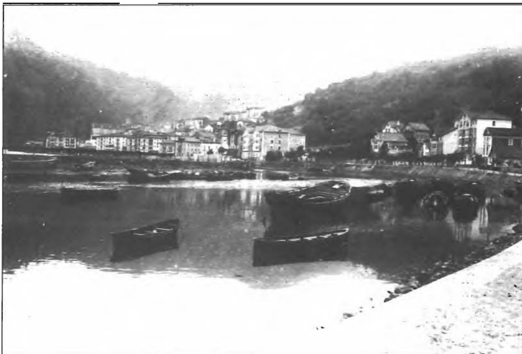
Etxe barriak itxas aldera. Nuevas construcciones.
