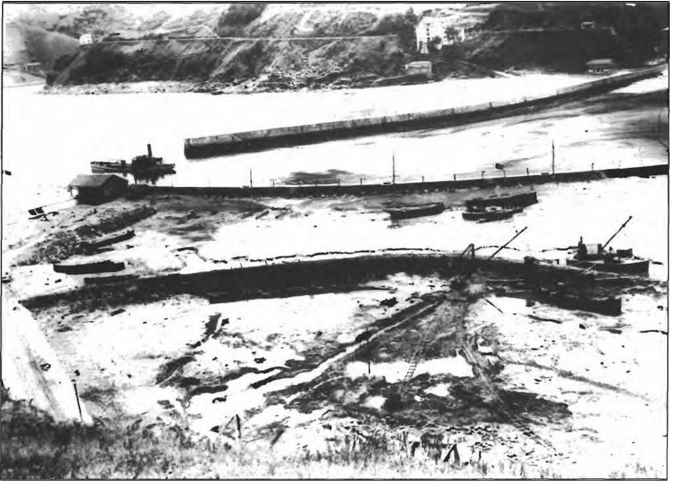
Portu barriaren asierako lanak. Empiezan los trabajos para el nuevo puerto.
